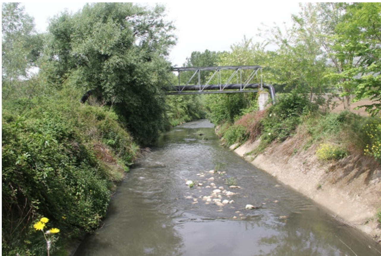
Escursione del 28.04.2017 – Ponte Carlo – Fiume Isclero – Moiano
