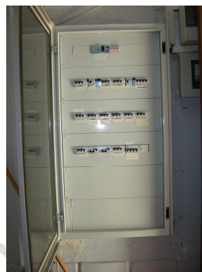
Foto.4 – Int. AT- Piano Terra
