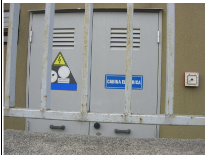
Foto.2 – Int. Generale esterno
