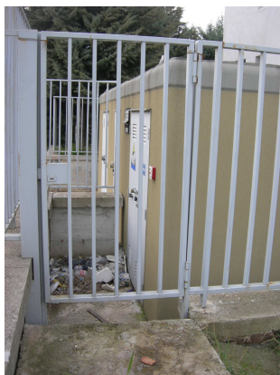
Foto.1 – Int. Generale esterno
